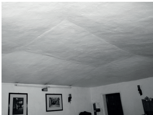
Bóveda planta alta.
